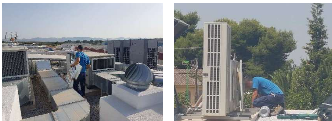
Figura 24. Tareas de mantenimiento y reparación al aire libre (fuente: estudio de campo en empresas del sector)
