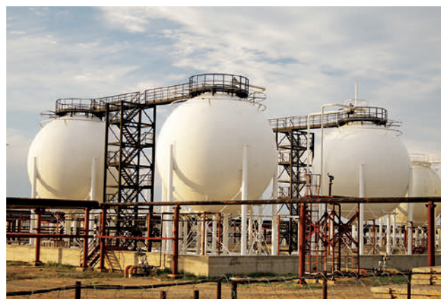
Figura 1. Almacenamiento de gas natural licuado a presión atmosférica y temperatura -161 °C. En su interior no hay aire luego no es de aplicación el Real Decreto 681/2003.
