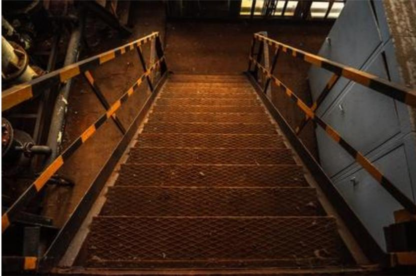
Se deberá utilizar para la fabricación de estos elementos acero inoxidable o aceros con capa de pintura de protección. Se deberán fabricar con un coeficiente de seguridad superior para conseguir una durabilidad mayor.
