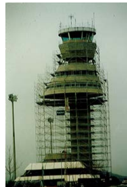
Torre de Control, Aeropuerto de Foronda, Vitoria.
