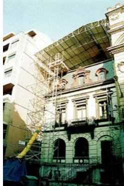
Cubierta Metálica Desmontable en Comandancia de Marina de Bilbao.
