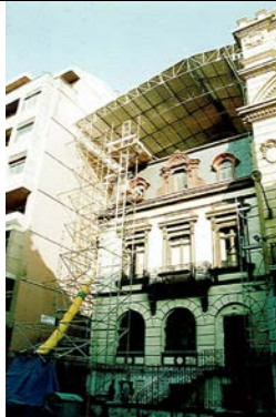
Cubierta Metálica Desmontable en Comandancia de
