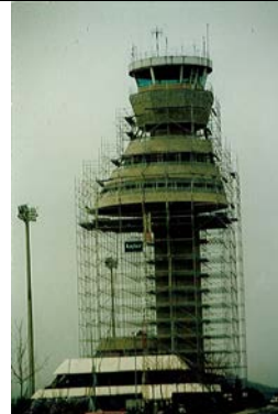
Torre de Control, Aeropuerto de Foronda, Vitoria.
