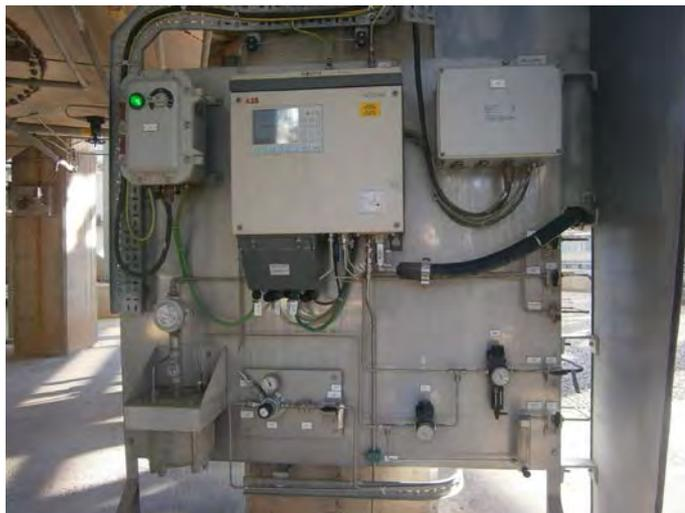
El usuario verificará que todos estos conductos están libres de fugas. Toda la instalación presurizada soportará una presión 1.5 veces la sobrepresión máxima de funcionamiento normal especificada por el fabricante.
