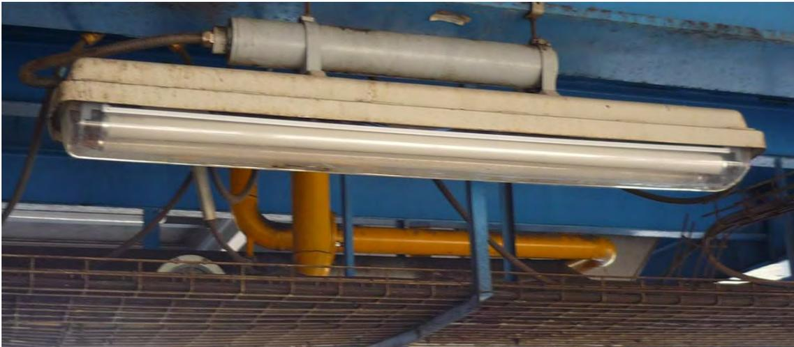
Este estado puede mantenerse a lo largo del tiempo de manera que puede convertirse en un verdadero peligro, debido al sobrecalentamiento del casquillo, del portalámparas o del tubo de vidrio, por encima de la clase de temperatura que certificó el fabricante para este equipo. Esto sucede especialmente en lámparas de diámetro pequeño, como las lámparas T5 ( $\varnothing$  16 mm) o las lámparas fluorescentes compactas.
