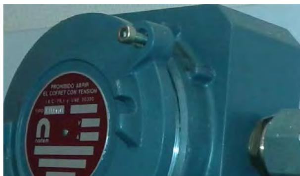
En las envolventes antideflagrantes, cuando se encuentren evidencias de desgaste, distorsión, corrosión u otro tipo de daños, hay que realizar la verificación según lo especificado en la documentación del equipo, de los juegos
