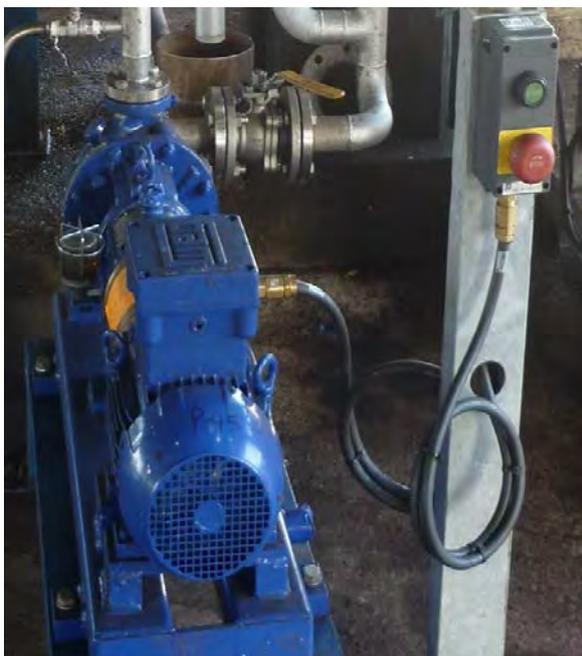
a) Empleo de materiales con una resistencia eléctrica superficial no mayor de  $1 \text{ G}\Omega$  (de acuerdo a lo indicado en el apartado 7.3.2 de UNE-EN 60079-0:2005). Se garantizará una unión equipotencial a tierra con una resistencia no mayor de  $1 \text{ M}\Omega$ .
