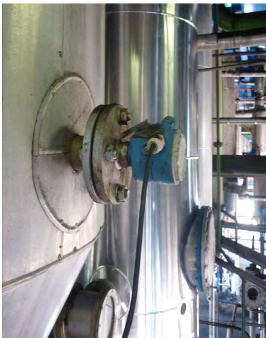
Comprobar que el cableado no tiene posibilidad de estar sometido a daños mecánicos, corrosión, influencias químicas efectos de la radiación UV. Si esto no ocurre, el cableado irá bajo tubo o se utilizará cable armado, apantallado, con cubierta de aluminio sin soldadura, con aislamiento mineral y cubierta metálica o cables con cubierta semirrígida.
