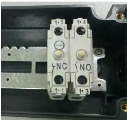
Las cajas de conexionado o empalme deberán ir provistas de algún sistema de fijación como por ejemplo guías donde irán instaladas regletas de conexión rápida.
