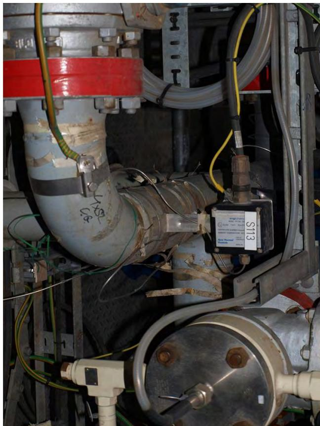
El funcionamiento de estos termostatos va ligado a la colocación de sensores en la superficie del equipo a calentar.
